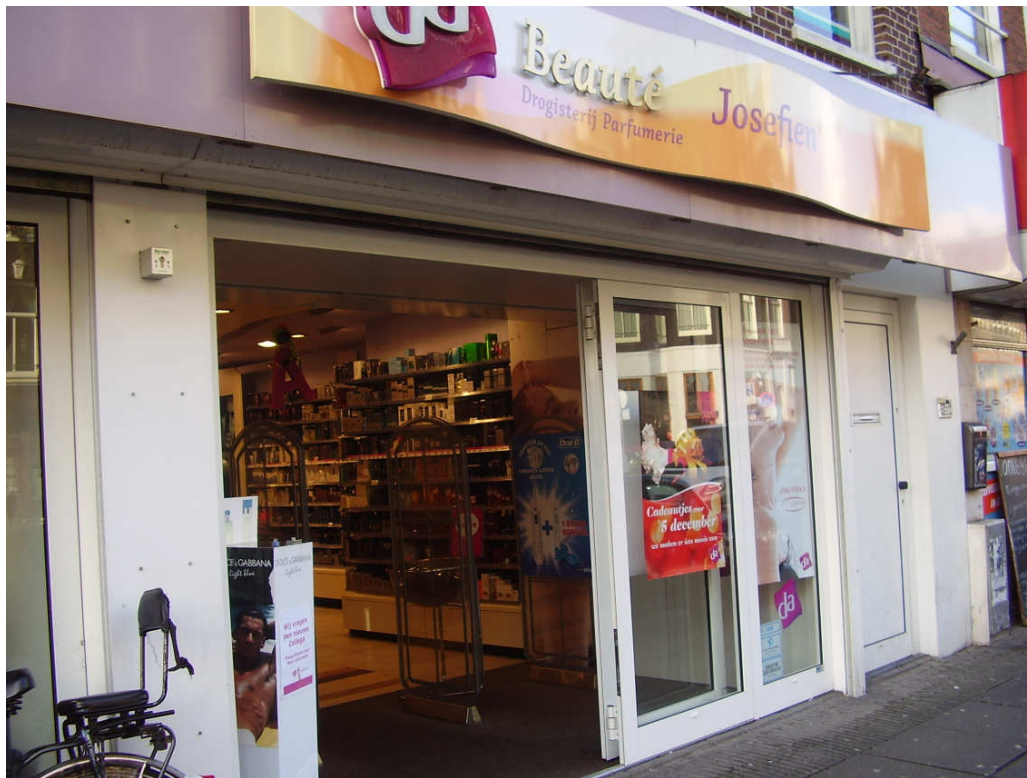
Figuur 1.1 Voorgevel DA drogist (oude deur)
